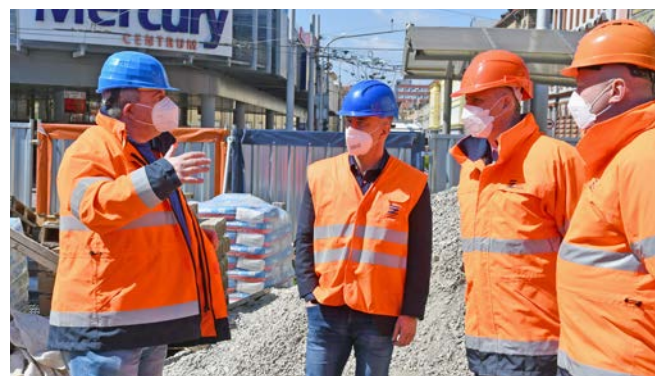
Martin Kuba na prohlídce stavebních prací
